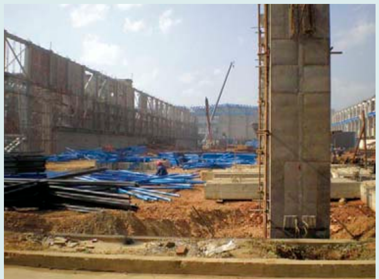
Construcción Civil de la nueva sala de estanques de la refinería de cobre de 180 ktpa en Yunnan Copper
