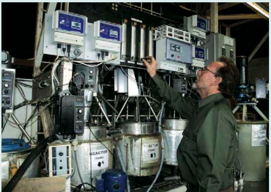
Pruebas piloto para el Proyecto Las Lagunas fueron realizadas en la planta HRLtesting en Brisbane
